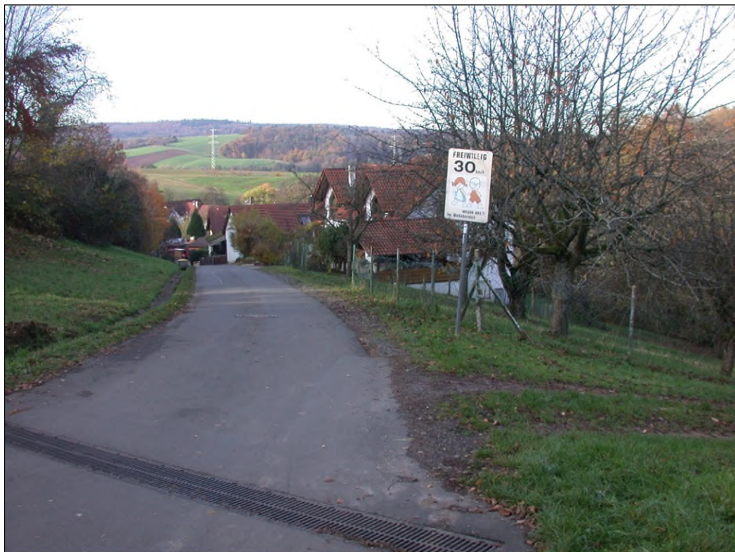
Abb. 7: Blick in den Schnellertsweg in Richtung Westen (Teilgebiet A) Quelle: Eigene Erhebung
